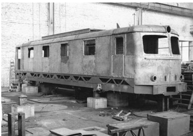
Rozpracovaná hrubá stavba skříňové lokomotivy E 499.1 v jedné z hal výrobního závodu v Plzni. (fovární foto Škoda, SOA Plzeň)
